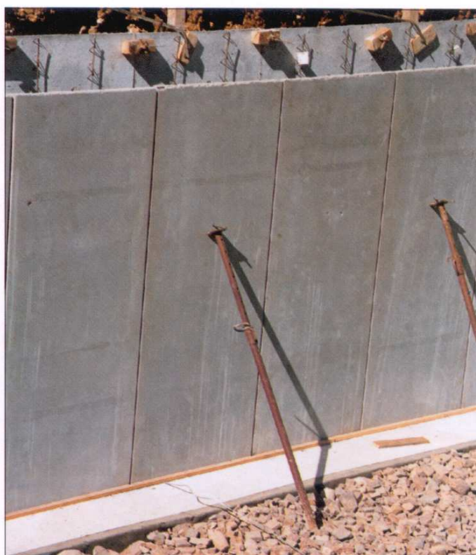
FISSAGGIO DOPPIE LASTRE CON PUNTELLI E MORSETTI
